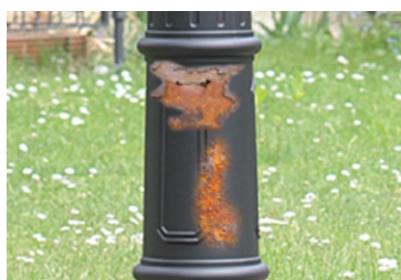
Cột, chóa đèn bằng kim loại bị rỉ sét
